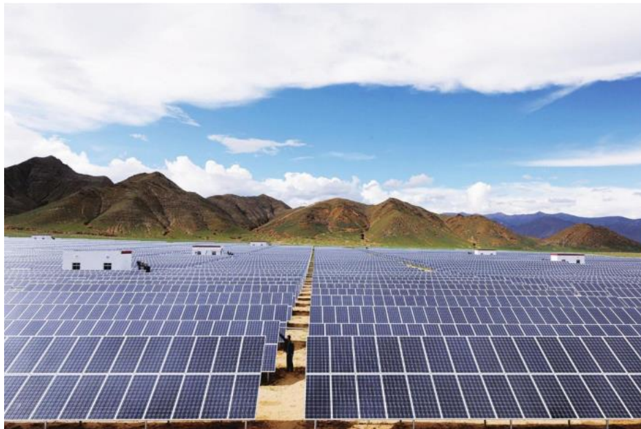
图 2.2-11 固定式光伏方阵示意图（固定支架）
